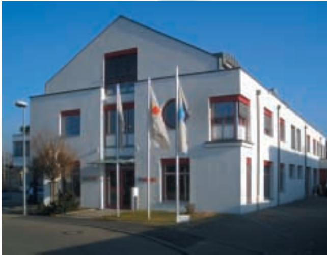
Unser Firmengebäude in Stuttgart.
